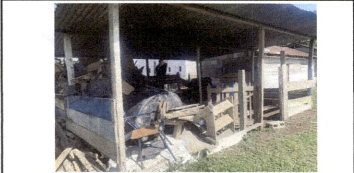
Foto 8: Cocina con acumulación de objetos no deseables.
