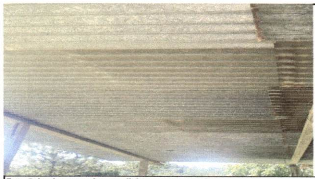
Foto 5: lamina en malas condiciones por corrosion.
